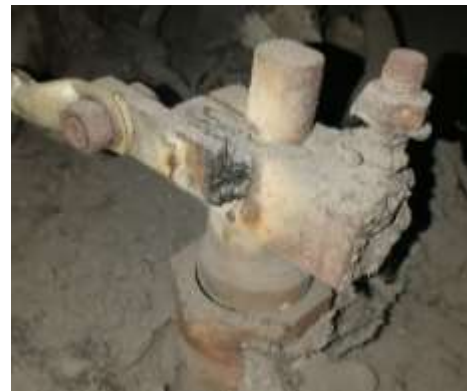
Рисунок 9-Состояние контактных узлов нагревательных элементов (на левом снимке отсутствует стяжной болт, фиксация узла на стержне за счет сварки)
