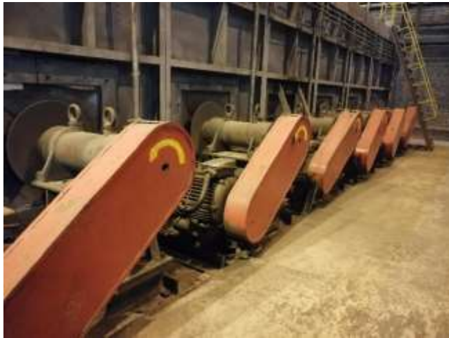
Рисунок 3 – центробежные вентиляторы
